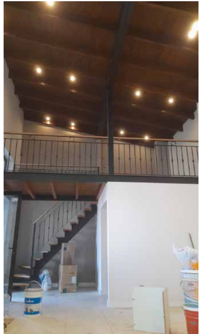
El entepiso, casi en final de obra.
